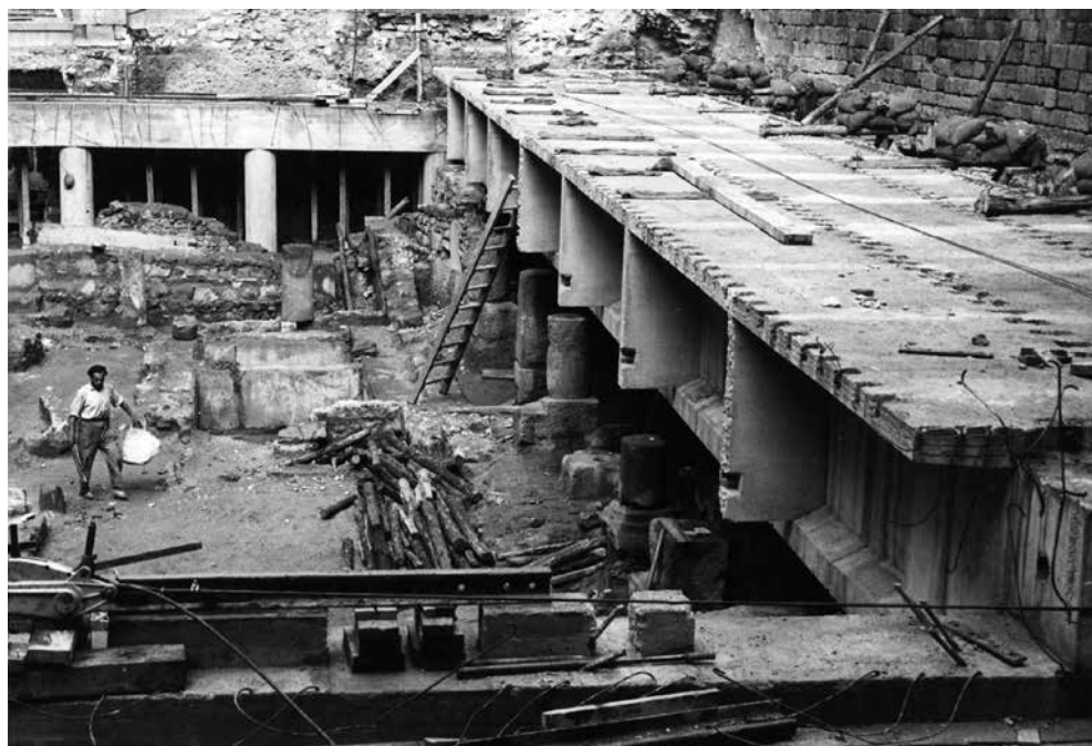
Fig. 1. Construction of the roof in the excavations of Plaça del Rei, 1961. (photo Museu d'Història de Barcelona, MUHBA Archives)
