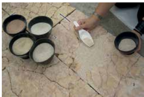
Fig. 6. Filling lacunae and joints with marble grit in seven different tones (Museu de Prehistòria de València)
