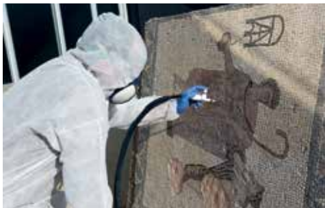
Fig. 8. Final cleaning: micro-blasting using glass microspheres (photo Centre de Restauració de Béns Mobles de Catalunya)
