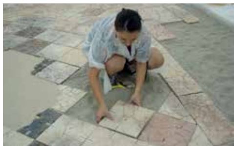
Fig. 5. Positioning and levelling of the numbered marble slabs on sand (Museu de Prehistòria de València)
