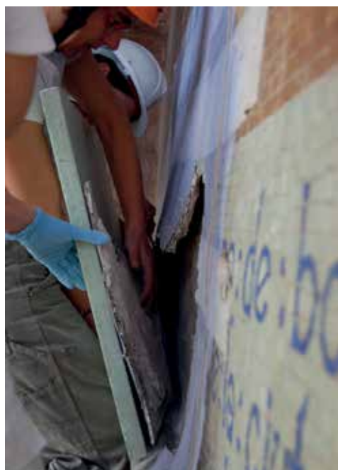
Fig. 10. Detachment of the bulged area (photo Àbac Conservació i Restauració SL)
