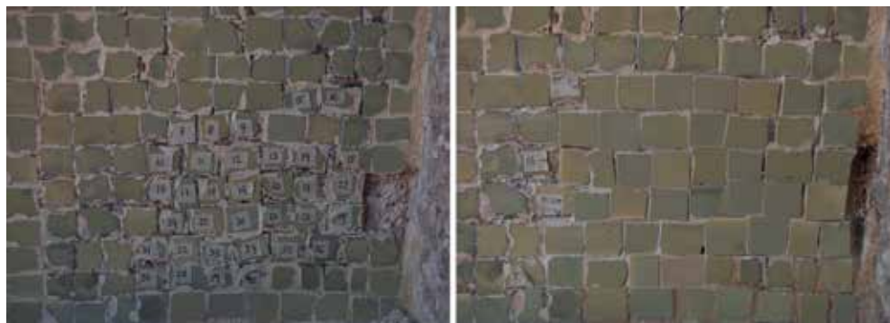
Fig. 8. Left: tesserae with enamel loss. Right: the same tesserae turned upside down (photo Àbac Conservació i Restauració SL)
