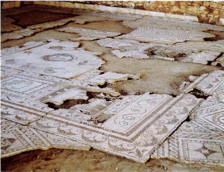
Fig. 2 : Armira (Ivailovgrad), villa romaine du II e siècle. Dégradation des mosaïques en raison de l'emploi de résine époxyde.
