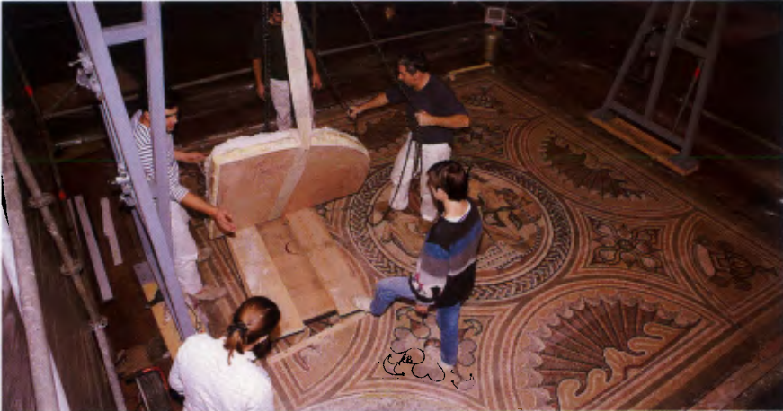
Fig. 2 : Dépose de la mosaïque d'Hylas scellée sur béton au Musée de Grenoble en 1903.
