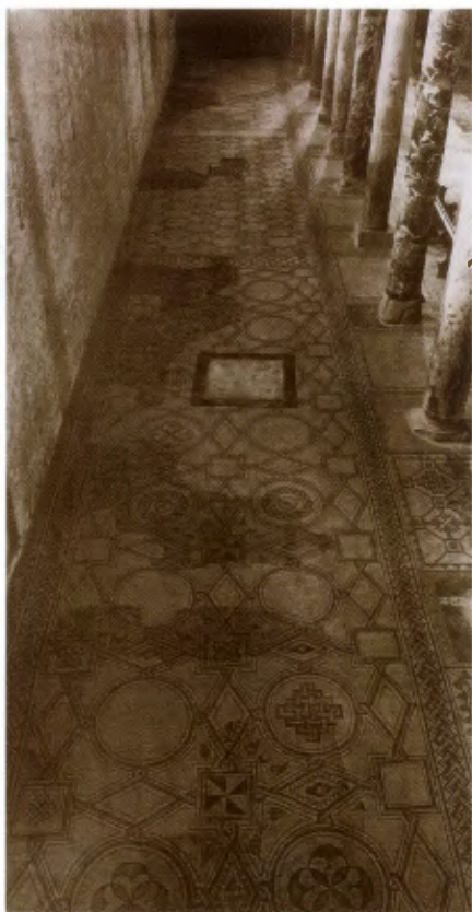
Fig. 6 : Basilichetta di Petrus. Navate laterale destra a restauro ultimato. (Foto archivio ing. V. De Grassi).
