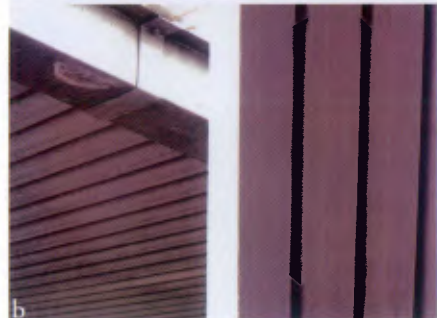
Fig. 4 : Détails de la couverture : a/ surface occupée par une colonne de soutien ; b/ surface métallique : joints et condensation.
