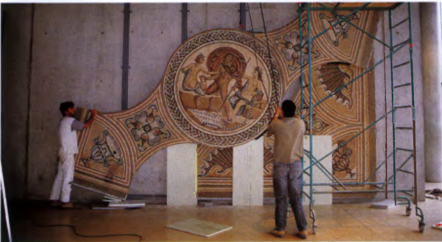
Fig. 3 : Installation au Musée de Saint-Romain-en-Gal de la mosaïque après son remontage sur nid d'abeilles .
