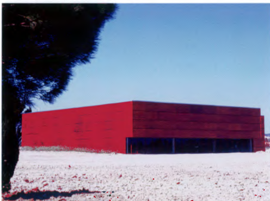
Fig. 2 : Le bâtiment de protection des mosaïques de la villa des Prés-Bas. (Cliché M. Lugand).
