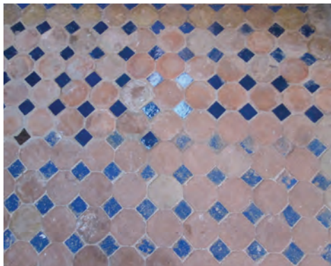
Fig. 15. Ouvrage transparent ( Shghal bān ) : Pièces octogonales ( Kūra ) bordées aux quatre côtés par des carrés étoilés (pavage du vestibule d'entrée de Fondouk al-Hanna à Meknès) (cliché : A. El Khammar)
