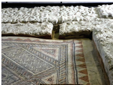
Fig. 13. Détail des enduits reposés en partie basse des murs (Cliché : Atelier)
