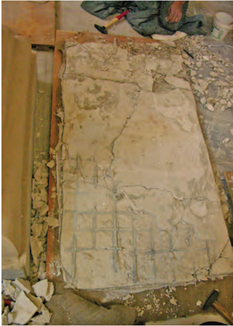
Fig. 2. Alexandrie, Musée gréco-romain : Pavement nilotique de Thmouis, plaque de ciment armé sous-jacente (en cours de restauration) (cliché : H. Tewfik, Archives CEALex)
