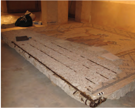
Fig. 3. Armatures en fer clairement visibles suite au nettoyage des comblements de ciment
