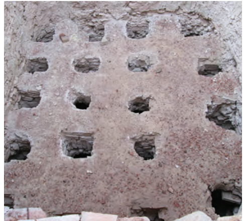
Fig. 8. Vue de la sole ( ghurbal ) d'un four de zellij : Nouveau quartier d'al-Fakhārīn à Meknès (al-Rmīka) (cliché : A. El Khammar)
