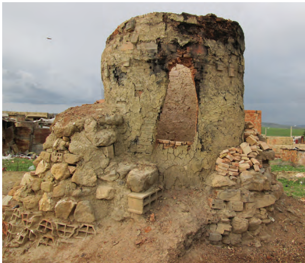
Fig. 5. Vue générale d'un four de zellij : Nouveau quartier d'al-Fakhārīn à Meknès (al-Rmīka) (cliché : A. El Khammar)
