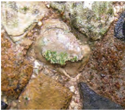
Fig. 13. Micro-organismes : dégâts structurels (cliché : Moudi Hani)
