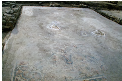
Fig. 3. Multiples altérations du tessellatum (cliché : S. Ferdi)
