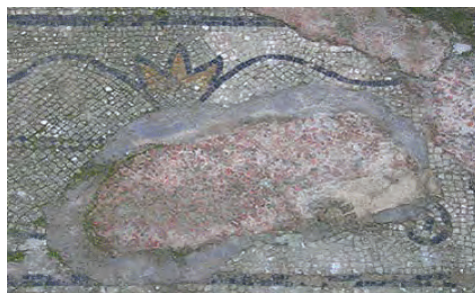
Fig. 6. Interventions précédentes inadéquates (cliché : Moudi Hani)
