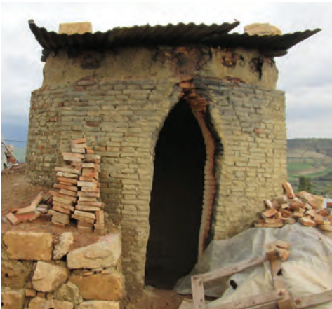
Fig. 7. Vue de la partie supérieure d'un four de zellij : Nouveau quartier d'al-Fakhārīn à Meknès (al-Rmīka) (cliché : A. El Khammar)
