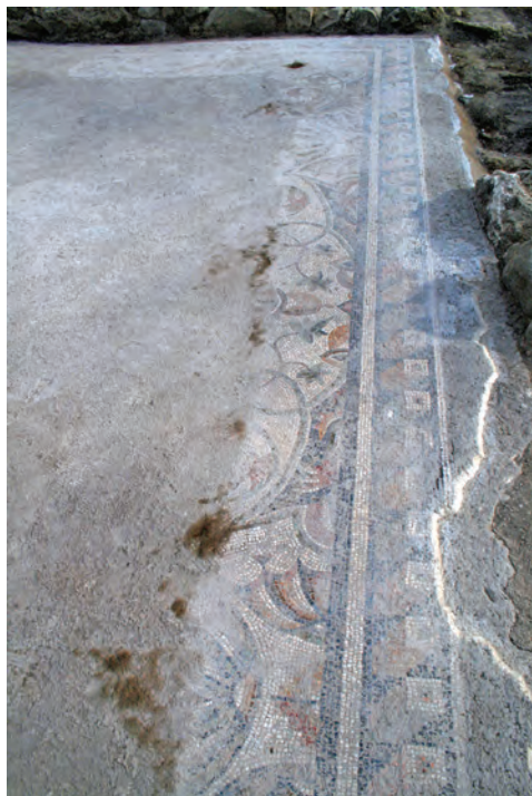
Fig. 4. Consolidation des bords du pavement par des solins de mortier de chaux (cliché : S. Ferdi)
