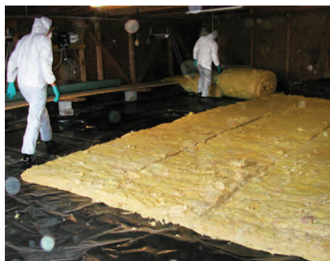
Fig. 9 a-b. Une couverture multicouche protège le pavement du dessèchement et des changements de température (clichés : SMRA)
