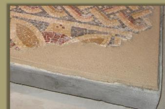
•Les bordures extérieures des panneaux ont été reconstruites ou complétées en ciment afin de garantir une surface résistante et nivelée capable de supporter le poids important des pavements lors de leur accrochage
