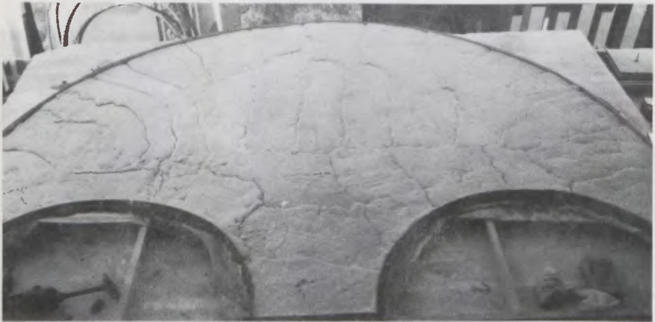
Fig. 14 Le nouveau mortier de support des tesselles.
