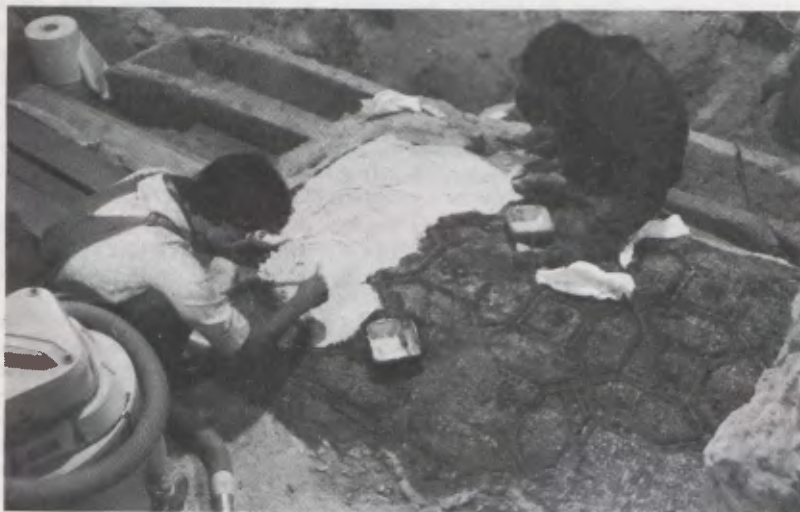
application de la membrane en élastomère silicone
