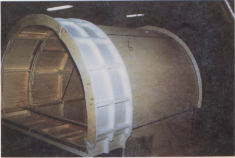
Fig. 2.- Contraforma cimbreada en madera y forma temporánea en fibra de vidrio (vetroresina)
