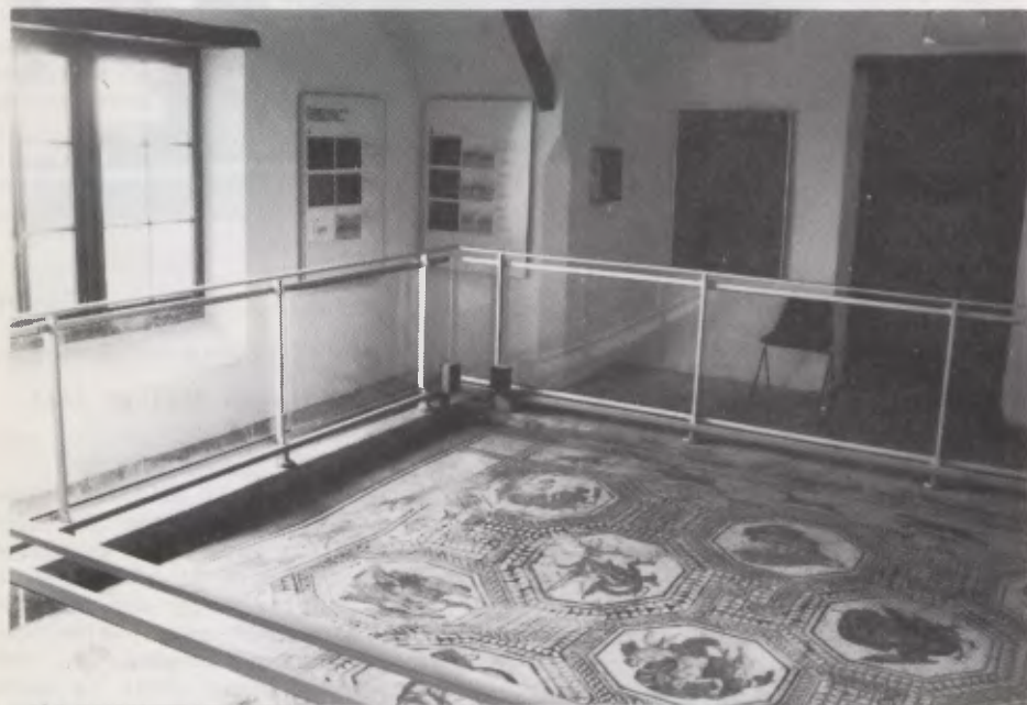
Fig. 4.- Bâtiment de protection (1862) de la mosaïque des Divinités. Les tassements de la mosaïque sont perceptibles. Nouvelles barrières avec plexiglas et dispositif d'alarme.
