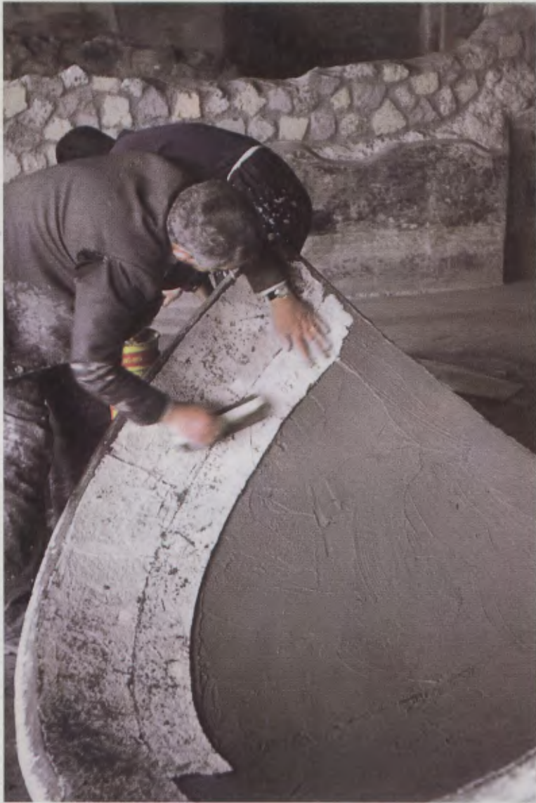
Fig. 4.- Aplicación de los trozos del mosaico separado sobre la forma temporánea en fibra de vidrio, mediante una capa de argamasa.
