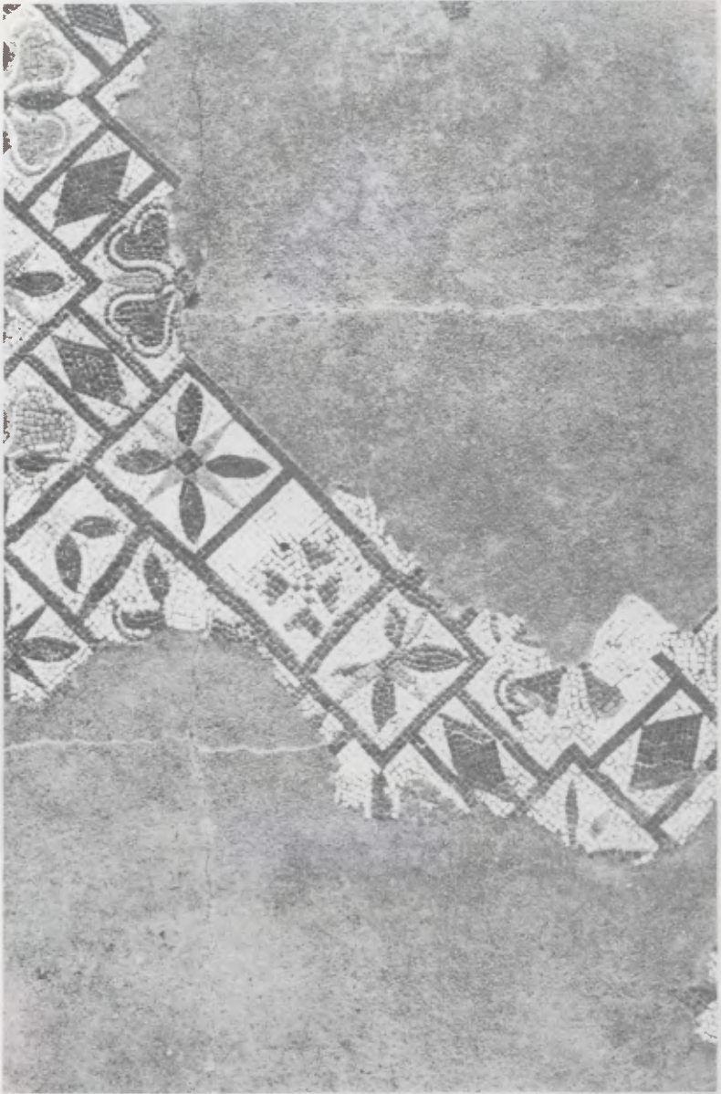
Fig. 2.- Hendiduras junto a uniones de placas de cemento armado.
