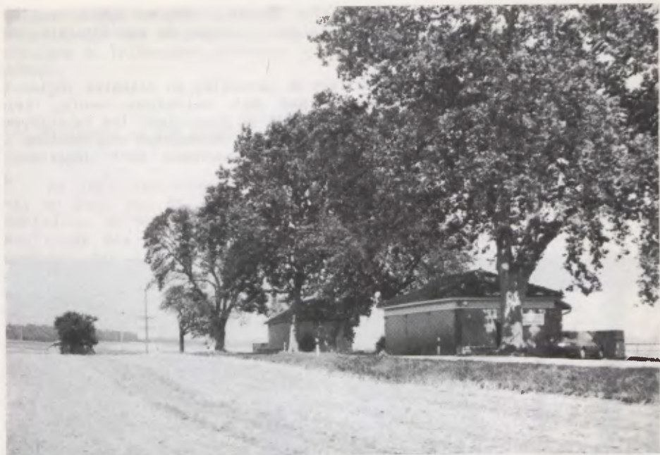
Fig. 3.- Deux bâtiments de protection construits en 1843 et 1862, à proximité de la route cantonale.
