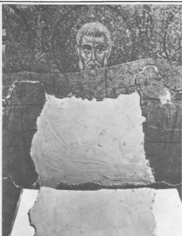
Fig. 5: La nouvelle couche de mortier est prête pour recevoir la mosaïque.
