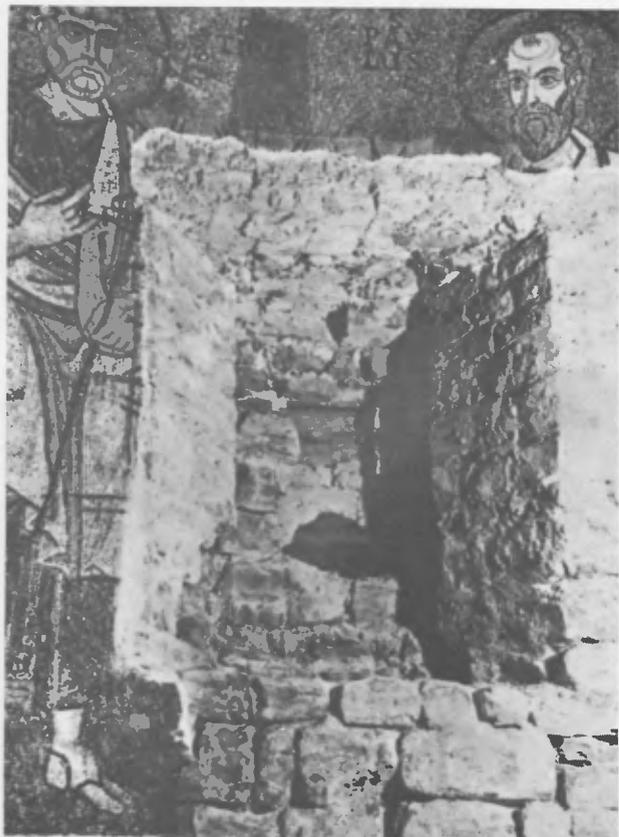
Fig. 8: Au cours de cette campagne, l'enlèvement de la mosaïque, des mortiers successifs ainsi que le nettoyage de la maçonnerie ont permis la découverte de fenêtres appartenant à une phase antérieure à celle qui décora l'abside de mosaïques.
