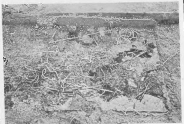
Fig. 14- SAINT PAUL LES ROMAINS en enlevant les dalles de béton, nous découvrons un réseau de racines et de galeries creusées par les mulots.
