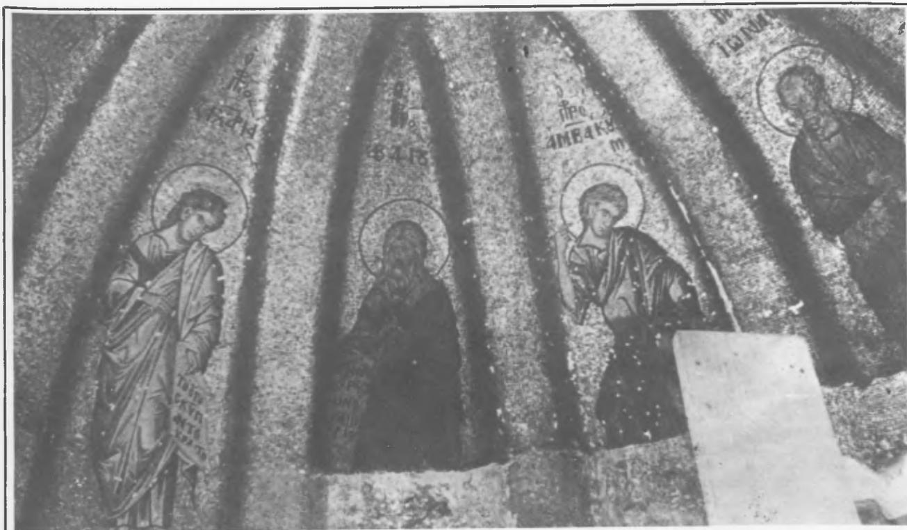
Fig. 6 - Dôme de la Fatiye Djami à Istanbul pendant la restauration. Le rejointoiement au mortier a été enlevé dans la partie inférieure de la mosaïque et des crampons ont été employés pour refixer la mosaïque à la maçonnerie.
