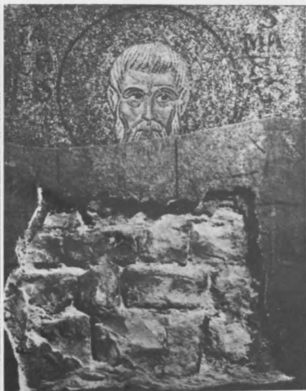
Fig. 4: Le mortier totalement enlevé laisse voir la maçonnerie en pierre.
