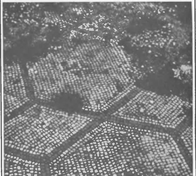
Fig. 1-2: Exemple de dégâts causés par la présence d'herbes.
