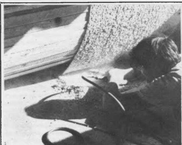
Fig. 3 - Nettoyage de l'envers des tesselles avec un petit marteau compresseur.
