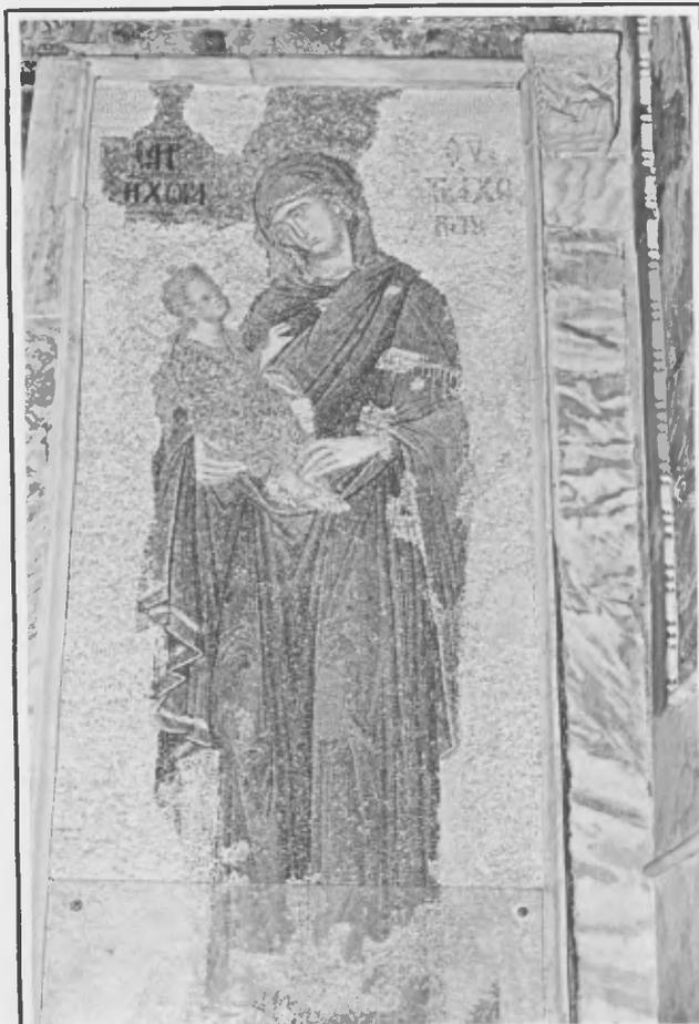
Fig. 3: Les tessères se sont détachées laissant apparaître le bain de pose original.
