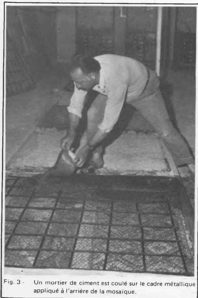
Fig. 3 - Un mortier de ciment est coulé sur le cadre métallique appliqué à l'arrière de la mosaïque.
