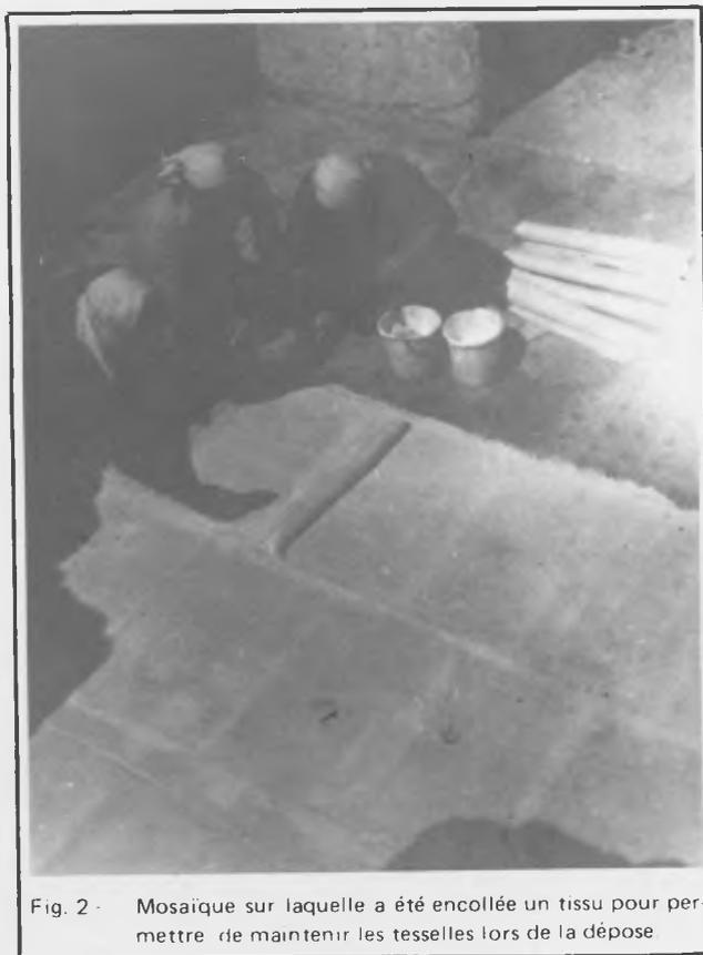
Fig. 2 - Mosaïque sur laquelle a été encollée un tissu pour permettre de maintenir les tesselles lors de la dépose.
